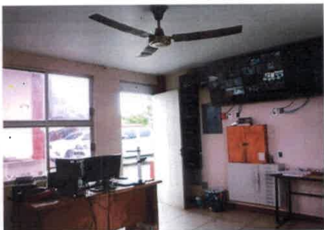
Instalacion de paneles de control
