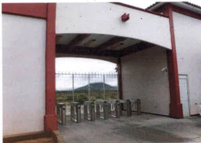
Vista de perfil acceso peatonal de la UNSI
